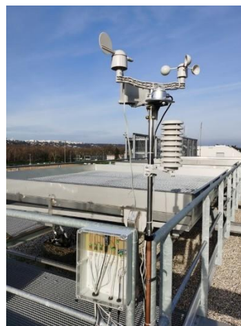
Figure 1. Station météorologique à bas coût installée sur la plateforme expérimentale GROOF avec (de gauche à droite et de haut en bas) : anémoscope, anémomètre, pluviomètre (à l'arrière), pyranomètre, et capteur de température, humidité et pression de l'air.
